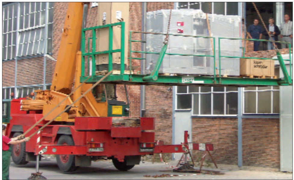
Bild 2. Einbringung der Blockheizkraftwerke von Sokratherm im Juni 2007
