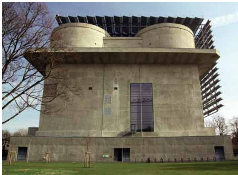
Bild 1. Aus dem ehemaligen Flakbunker, der im 2. Weltkrieg bis zu 30 000 Menschen Schutz bot, wurde im Jahr 2011 der Energiebunker Hamburg – unter anderem mit einer Solarthermieanlage auf dem Dach, einer Photovoltaikanlage an der Südseite der Fassade und einem BHKW im Inneren.
