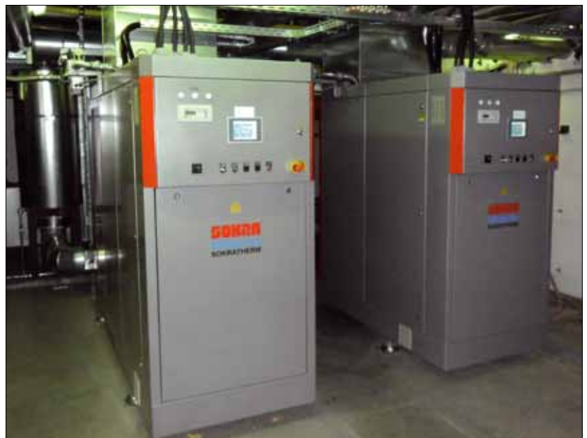
Bild 1. BHKW-Anlage am Standort Düppel (2 x GG 140)
