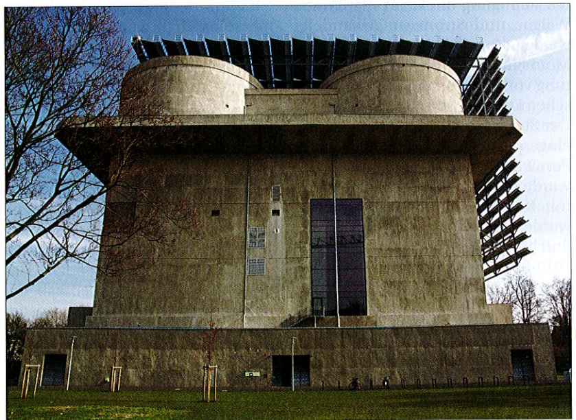
Bild 1. Aus dem ehemaligen Flakbunker, der bis zu 30 000 Menschen Schutz bot, wurde im Jahr 2011 der Energiebunker Hamburg – unter anderem mit einer Photovoltaikanlage auf dem Dach und einer Solarthermieanlage an der Südseite der Fassade
