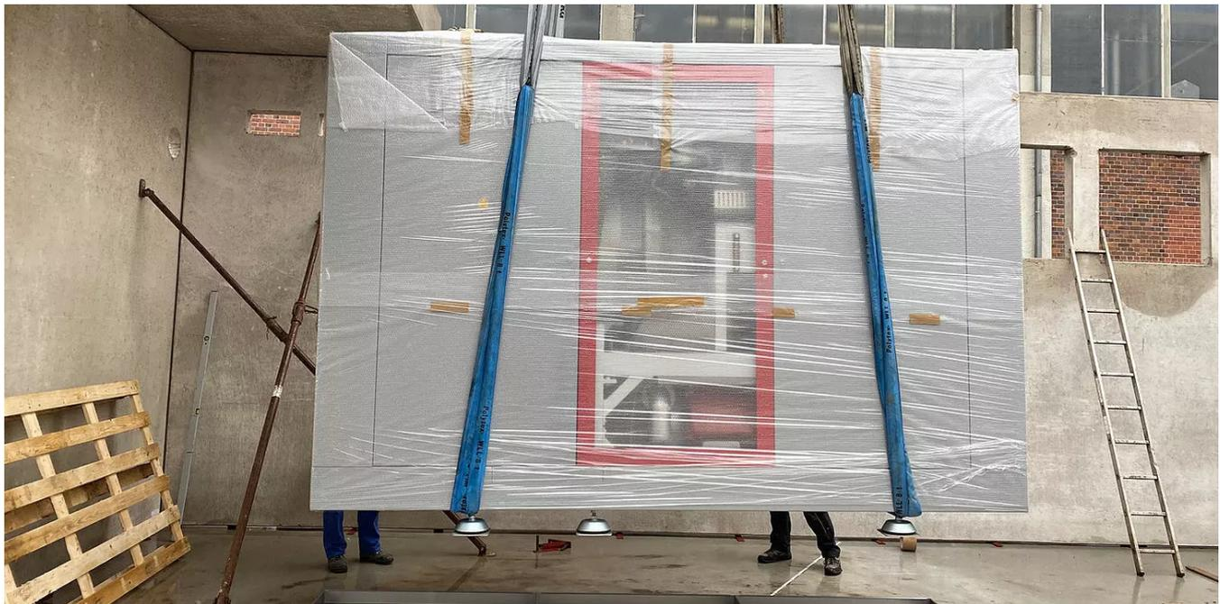
**Einbringung eines der beiden BHKW-Kompaktmodule GG 530 für den Tierpark Berlin per Kran.**
