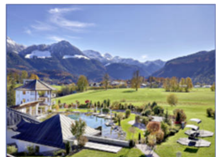
3 BHKW-Kompaktmodule GG 50 6VRSB Alpenhotel Zechmeisterlehen, Schönau
