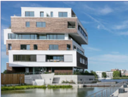
3 BHKW-Kompaktmodule GG 100 Wohnanlage 52° Nord, Berlin-Grünau
