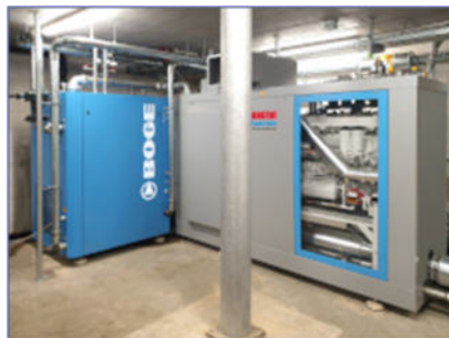
Gasmotor-Kompressormodul GK 140 zur Erzeugung von Druckluft und Wärme Industriebetrieb Heckler & Koch, Oberndorf
