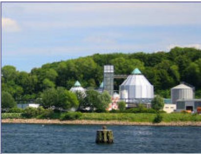
3 BHKW-Kompaktmodule FG 250 Kläwerk Kielseng, Flensburg
