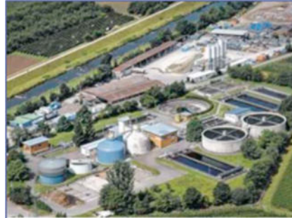
2 BHKW-Kompaktmodule FG 50 mit Ersatzstromfunktion Kläranlage, Oberkirch
