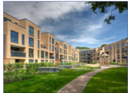
BHKW-Kompaktmodul GG 260 Wohnanlage Poppenbütteler Berg, Hamburg
