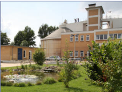
BHKW-Kompaktmodul FG 250 im Container aufgestellt Kläranlage Herford
