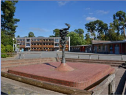
BHKW-Kompaktmodul GG 50 Schuldorf Bergstraße, Seeheim-Jugenheim
