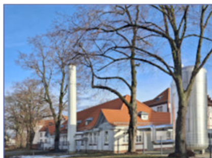
BHKW-Kompaktmodul GG 202 mit Sole/Wasser und Luft/Wasser WP Alanbrooke Quartier Paderborn
