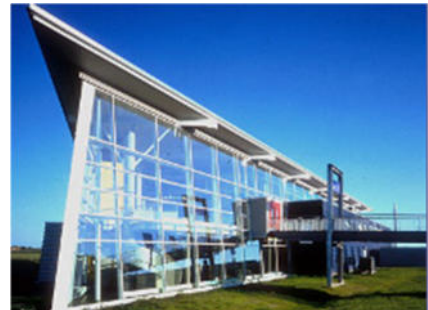
BHKW-Kompaktmodul GG 70 H mit Absorptionskältemaschine zur Klimatisierung Multimar Wattforum, Tönning
