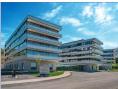
BHKW-Kompaktmodul GG 100 im Container mit Notstrom- und Kälteerzeugung Firmengebäude "The SUMMIT", Siegen
