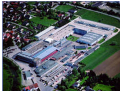
2 BHKW-Kompaktmodule GG 237 mit Ersatzstromfunktion Spannzeugfabrik, Röhm, Sontheim
