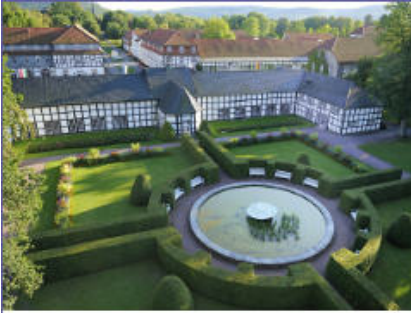
2 BHKW-Kompaktmodule GG 237 1 BHKW-Kompaktmodul GG 140 Hotel & Spa, Gräflicher Park, Bad Driburg
