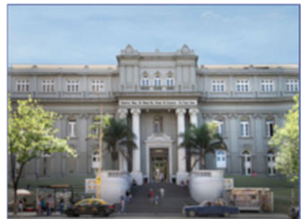
BHKW-Kompaktmodul GG 50 Kinderkrankenhaus, RA-Buenos Aires
