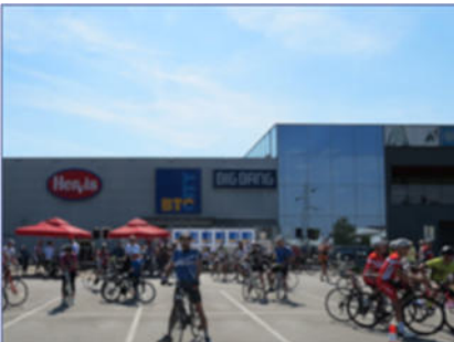
BHKW-Kompaktmodul GG 50 Einkaufszentrum BTC City, SLO-Murska Sobota
