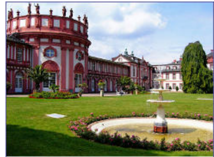
BHKW-Kompaktmodul GG 50 mit Ersatzstromfunktion Schloss Biebrich, Wiesbaden
