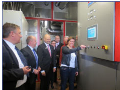
BHKW-Kompaktmodul GG 530 mit zusätzlicher Einhausung Thiebautschule Ettlingen
