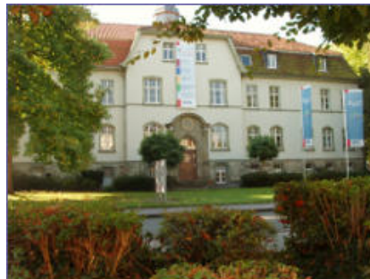
2 BHKW-Kompaktmodule GG 140 LWL-Klinik Lippstadt
