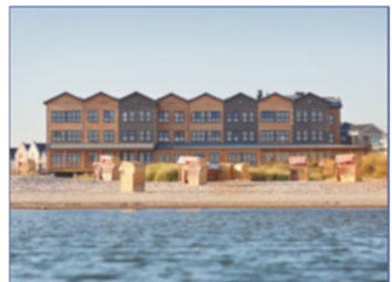
BHKW-Kompaktmodul GG 70 Hotelanlage "Bretterbude", Heiligenhafen Hotelimmobilie des Jahres 2017
