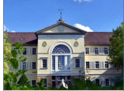
BHKW-Kompaktmodul GG 237 Kurhaus und Rehaklinik Bad Boll
