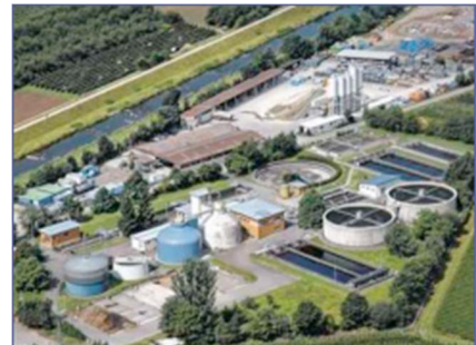
2 BHKW-Kompaktmodule FG 50 mit Ersatzstromfunktion Kläranlage, Oberkirch
