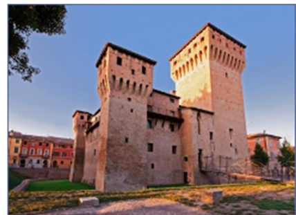
BHKW-Kompaktmodul GG 530 Nahwärmeverorgung, I-San Felice sul Panaro
