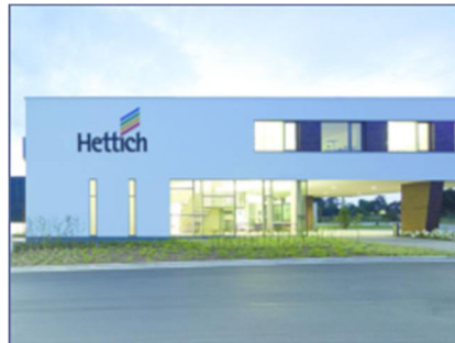
2 BHKW-Kompaktmodule GG 50 Fertigungshallen, Hettich, Kirchlegern
