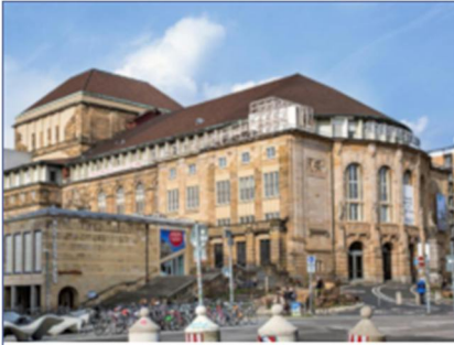
BHKW-Kompaktmodul GG 330 Stadtheater Freiburg
