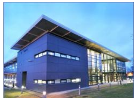
BHKW-Kompaktmodul GG 50 BHKW-Kompaktmodul GG 113 Cork Institute of Technology CIT, Cork (Irland)
