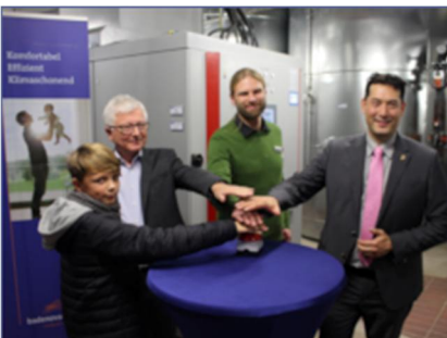
BHKW-Kompaktmodul GG 260 Heizkraftwerk Seidenfäden, Denzlingen
