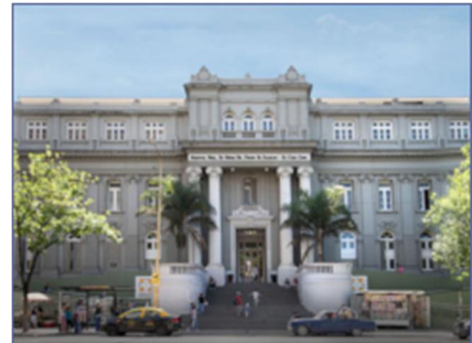
BHKW-Kompaktmodul GG 50 Kinderkrankenhaus, RA-Buenos Aires
