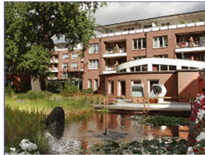
BHKW-Kompaktmodul GG 50 Seniorenwohnanlage, Parkresidenz Rahstedt, Hamburg
