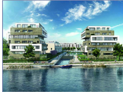
3 BHKW-Kompaktmodule GG 100 Wohnanlage "52° Nord", Berlin-Grünau
