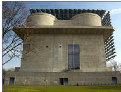
BHKW-Kompaktmodul GG 530 BHKW-Kompaktmodul GG 237 Energiebunker Hamburg-Wilhelmsburg
