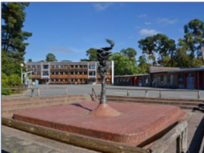
BHKW-Kompaktmodul GG 50 Schuldorf Bergstraße, Seeheim-Jugenheim
