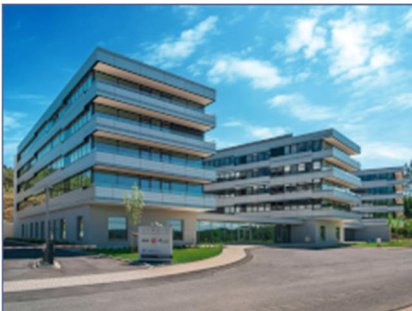
BHKW-Kompaktmodul GG 100 im Container mit Notstrom- und Kälteerzeugung Firmengebäude "The SUMMIT", Siegen
