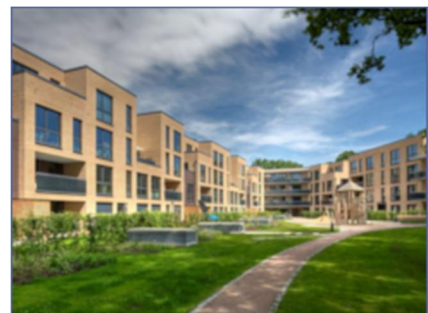
BHKW-Kompaktmodul GG 260 Wohnanlage Poppenbütteler Berg, Hamburg
