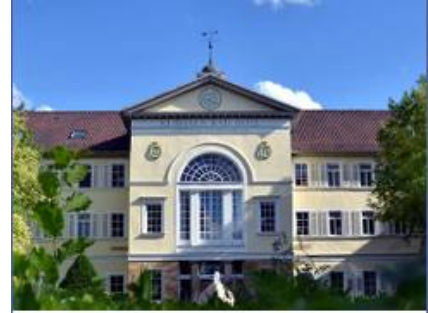
BHKW-Kompaktmodul GG 237 Kurhaus und Rehaklinik Bad Boll
