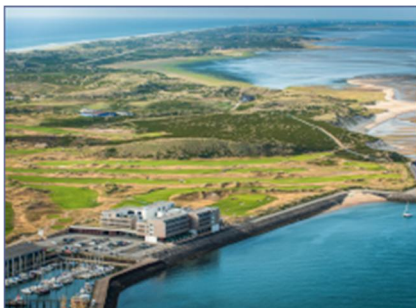
BHKW-Kompaktmodul GG 70 Budersand Hotel Golf & Spa, Hömum (Sytt)
