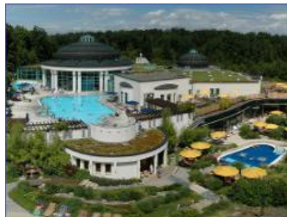
BHKW-Kompaktmodul GG 113 BHKW-Kompaktmodul GG 140 Mineraltherme Böblingen
