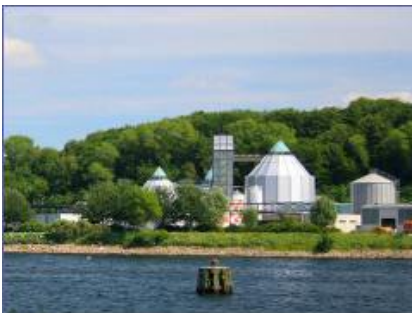
3 BHKW-Kompaktmodule FG 250 Kläranlage Kielseng, Flensburg
