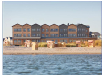
BHKW-Kompaktmodul GG 70 Hotelanlage "Bretterbude", Heiligenhafen Hotelimmobilie des Jahres 2017
