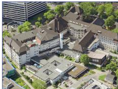
BHKW-Kompaktmodul GG 402 Elisabeth-Krankenhaus Essen
