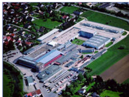
2 BHKW-Kompaktmodule GG 237 mit Ersatzstromfunktion Spannzeugfabrik, Röhms, Sontheim
