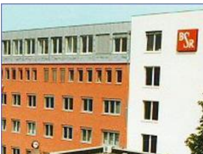
BHKW-Kompaktmodul GG 237 H Hauptwerkstatt 2, Berliner Stadtreinigung BSR
