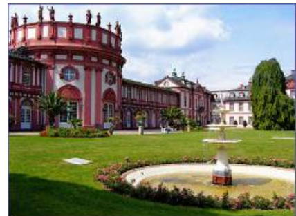
BHKW-Kompaktmodul GG 50 mit Ersatzstromfunktion Schloss Biebrich, Wiesbaden
