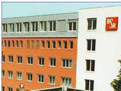
BHKW-Kompaktmodul GG 237 H Berliner Stadtreinigung BSR, Hauptwerkstatt 2
