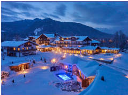
1 BHKW-Kompaktmodul GG 70 1 BHKW-Kompaktmodul GG 50 Alpenhotel Zechmeisterlehen, Schönau
