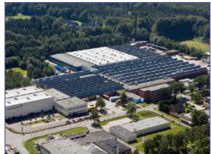
1 BHKW-Kompaktmodul GG 402 1 BHKW-Kompaktmodul GG 402 H GRUNDFOS Pumpenfabrik GmbH, Wahlstedt
