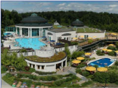
1 BHKW-Kompaktmodul GG 113 1 BHKW-Kompaktmodul GG 140 Mineraltherme Böblingen
