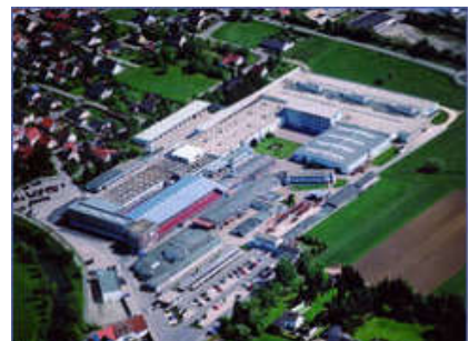
2 BHKW-Kompaktmodule GG 237 mit Ersatzstromfunktion Röhms GmbH, Sontheim
