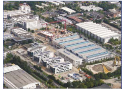
4 BHKW-Kompaktmodule GG 402 1 BHKW-Kompaktmodul GG 206 Sartorius Campus Göttingen
