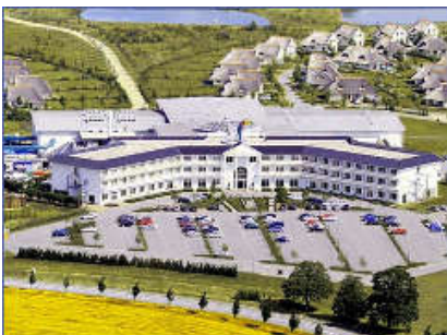
3 BHKW-Kompaktmodule GG 237 mit Ersatzstromfunktion Van der Valk Resort Linstow
