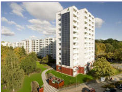
BHKW-Kompaktmodul GG 140 Wohnanlage, Laatzten
