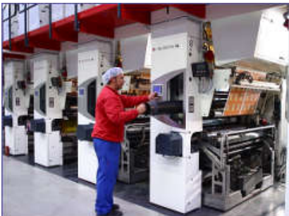
BHKW-Kompaktmodul GG 402 T Rahning GmbH & Co. KG Werk Tiefdruck, Bünde
