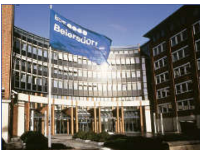
2 BHKW-Kompaktmodule GG 237 1 BHKW-Kompaktmodul GG 140 Beiersdorf AG Werke, Hamburg
