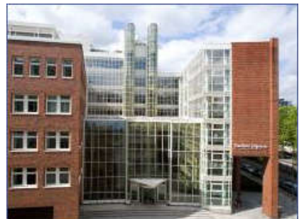
BHKW-Kompaktmodul GG 140 Frankfurter Allgemeine Zeitung (F.A.Z.) Verlagsgebäude, Frankfurt
