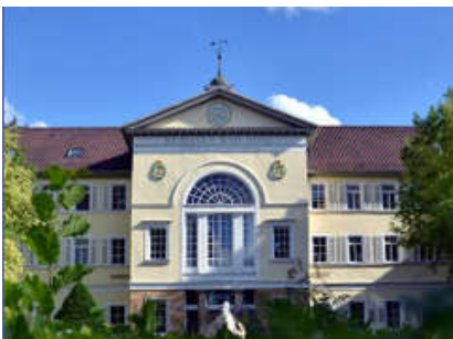
BHKW-Kompaktmodul GG 237 Kurhaus und Rehaklinik Bad Boll
