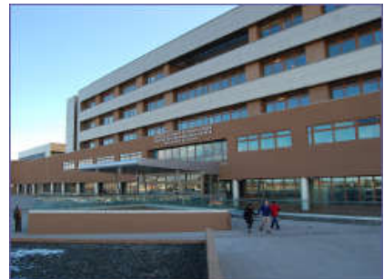
BHKW-Kompaktmodul GG 402 Hospital Clinico de Magallanes Punta Arenas, Chile
