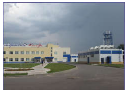
3 BHKW-Kompaktmodule GG 402 zur netzunabhängigen Stromversorgung Eiscremefabrik Kolibri, RUS-Nischni Nowgorod
