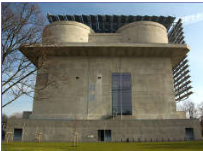
1 BHKW-Kompaktmodul GG 530 1 BHKW-Kompaktmodul GG 237 Energiebunker Hamburg-Wilhelmsburg
