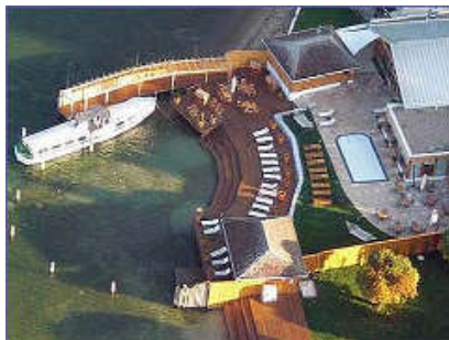
BHKW-Kompaktmodul GG 50 monte mare Seesauna, Tegernsee
