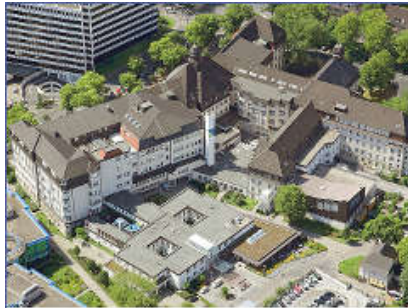
BHKW-Kompaktmodul GG 402 Elisabeth-Krankenhaus Essen
