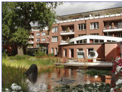
BHKW-Kompaktmodul GG 50 Parkresidenz Rahlstedt, Hamburg Seniorenwohnanlage
