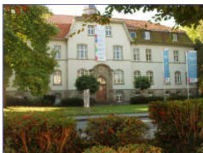
2 BHKW-Kompaktmodule GG 140 LWL-Klinik Lippstadt
