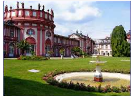
BHKW-Kompaktmodul GG 50 mit Ersatzstromfunktion Schloss Biebrich, Wiesbaden
