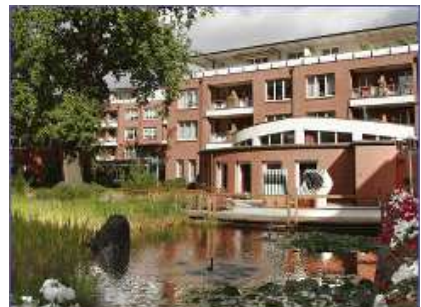
BHKW-Kompaktmodul GG 50 Pakresidenz Rahlstedt, Hamburg Seniorenwohnanlage
