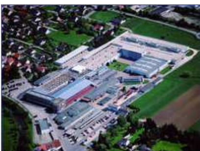
2 BHKW-Kompaktmodule GG 237 mit Ersatzstromfunktion Röhm GmbH, Sontheim
