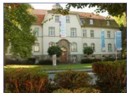
2 BHKW-Kompaktmodule GG 140 LWL-Klinik Lippstadt
