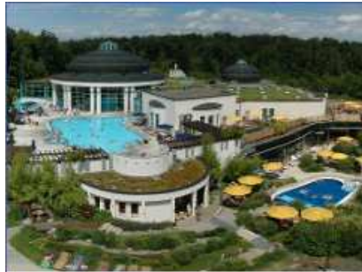
1 BHKW-Kompaktmodul GG 113 1 BHKW-Kompaktmodul GG 140 Mineraltherme Böblingen
