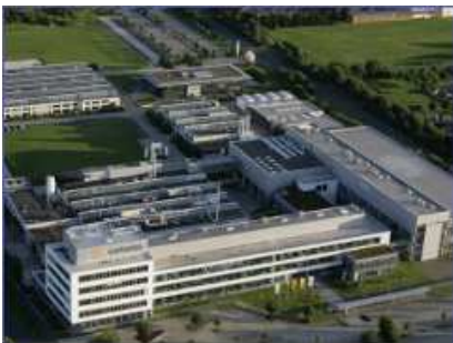
4 BHKW-Kompaktmodule GG 402 H mit Ersatzstromfunktion und Heißkühlung Sartorius Stedim Biotech GmbH, Göttingen
