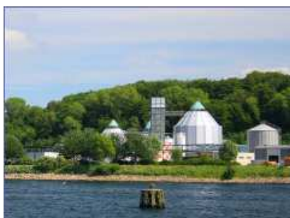
3 BHKW-Kompaktmodule FG 250 Kläwerk Kielseng, Flensburg
