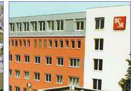
BHKW-Kompaktmodul GG 237 H Berliner Stadtreinigung BSR, Hauptwerkstatt 2
