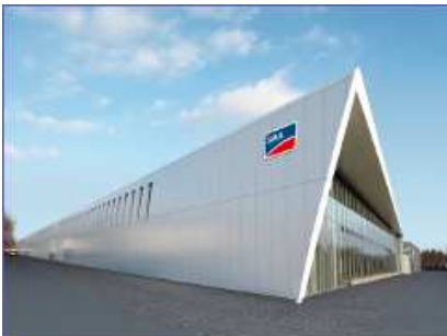
BHKW-Kompaktmodul GG 237 H SMA Solar Technology AG, Weik Kassel
