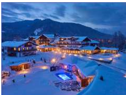
1 BHKW-Kompaktmodul GG 70 1 BHKW-Kompaktmodul GG 50 Alpenhotel Zechmeisterlehen, Schönau
