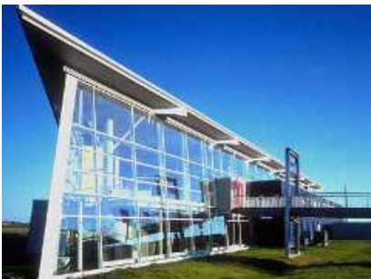
BHKW-Kompaktmodul GG 50 H mit Absorptionskältemaschine zur Klimatisierung Multimar Wattforum, Tönning
