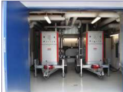
2 BHKWmobil GG 50 Im Sommer Freibad Enkenbach (Abbildung), im Winter Grundschule und Bürgerhaus
