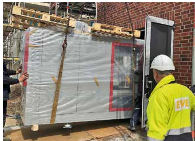
Einbringung des ersten BHKW-Moduls in der Energiezentrale.
