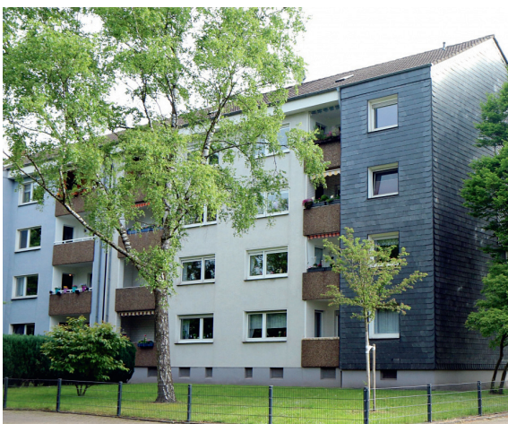
Pilotprojekt in der Wohnsiedlung in Oberhausen-Barmingholten: Maximierter Deckungsgrad des Wärmebedarfs bei zeitlich optimierter Stromproduktion.
