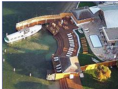
Compact CHP unit GG 50 monte mare lake sauna, Tegernsee
