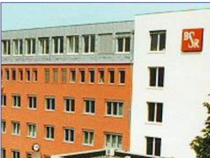
Compact CHP unit GG 237 H Berliner Stadtreinigung BSR
