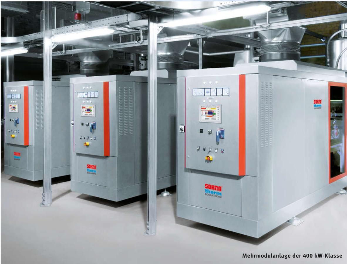
Die Kombination mehrerer BHKW-Kompaktmodule ermöglicht eine Energieversorgung im Megawattbereich.
