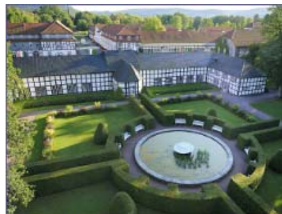
2 BHKW-Kompaktmodule GG 237 S Bad Driburg, Gräflicher Park: Kliniken, Hotel und Spa Resort
