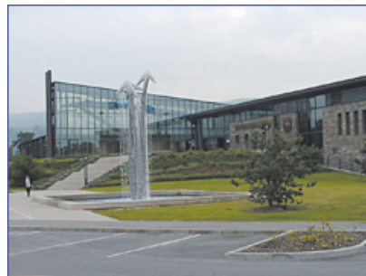
BHKW-Kompaktmodul GG 225 S Frankreich / Publier Freizeitbad Cité de l'eau
