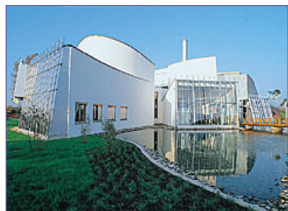
BHKW-Kompaktmodul GG 50 A Bad Oeynhausen, ENERGIE - FORUM - INNOVATION E.ON Westfalen-Wasser AG
