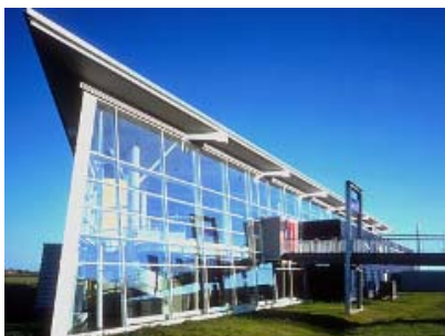
BHKW-Kompaktmodul GG 50 SH Tönning, Multi mar Wattforum Außenansicht
