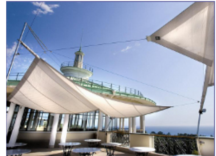
3 BHKW-Kompaktmodule GG 240 S Russland / Sotschi Kurhotel und Sanatorium Rodina
