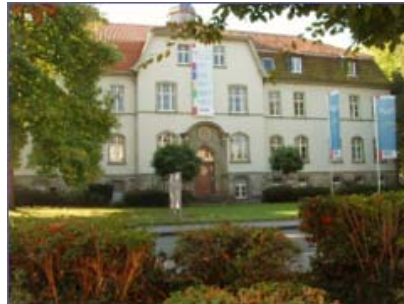
2 BHKW-Kompaktmodule GG 140 S Lippstadt, LWL-Klinik
