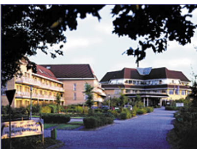
BHKW-Kompaktmodul GG 122 S Gladbeck, Hotel Van der Valk
