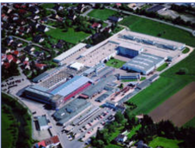
2 BHKW-Kompaktmodule GG 237 S Röhm GmbH, Sontheim
