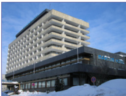
BHKW-Kompaktmodul GG 140 S Maritim Berghotel Braunlage, BHKW des Jahres 2009
