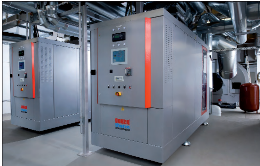
Bild 2. Doppelanlage: zwei BHKW-Kompaktmodule GG 237 S
