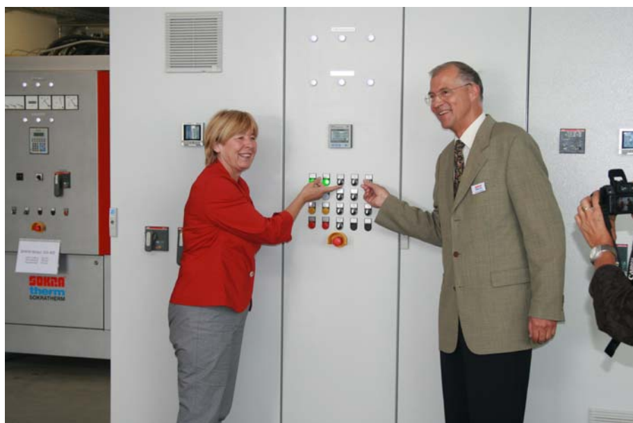
Die Nordhäuser Oberbürgermeisterin Barbara Rinke und Geschäftsführer Hermann Meinhold nehmen das BHKW-Kompaktmodul GG 402 auf dem neuen Prüfstand in Betrieb.
