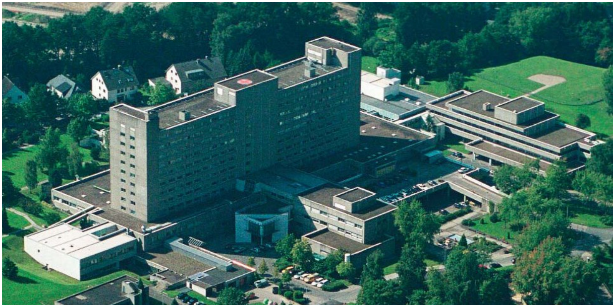
Bild 2: Im Klinikum Herford wird demnächst das 1.000ste BHKW-Kompaktmodul von SOKRATHERM installiert.
