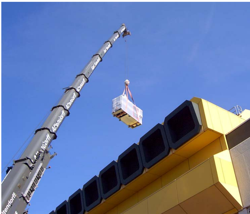
Abbildung 6: Einbringung des SOKRATHERM GG 383 S in der JVA Berlin-Tegel
